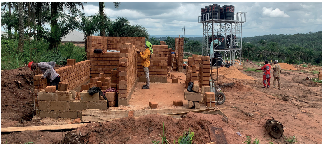
Arbeiter legen das Fundament ...
