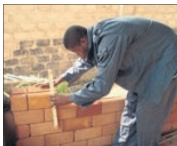
Lehmmauern ohne Mörtel und Putz.
