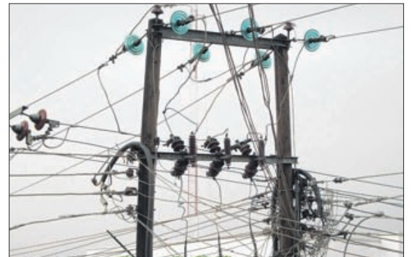
Die Mbara Site nächstgelegene Trafostation liegt 4 km entfernt.
