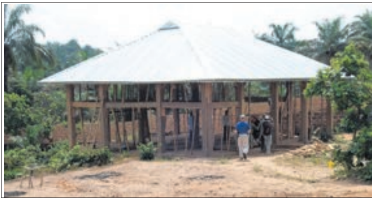
Das erste Gebäude des Welfare and Development Centre im Rohbau ...
