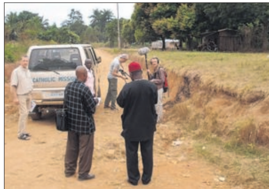
Über ca. 1 km wird von dieser Stelle aus das Projektgelände Mbara Site an das NEPA-Leitungsnetz angeschlossen.
